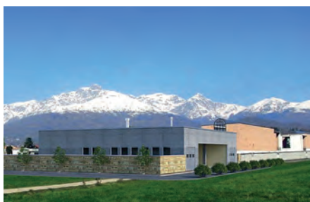
Il nuovo impianto crematorio di Biella.
